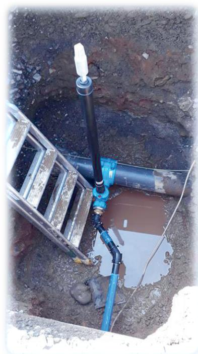
Ein Hausanschluss an eine bestehende PVC-Hydrantenleitung kann auch unter Druck ohne Netzabstellung angeschlossen werden (bis DN 50 / Aussendurchmesser 63 mm).
